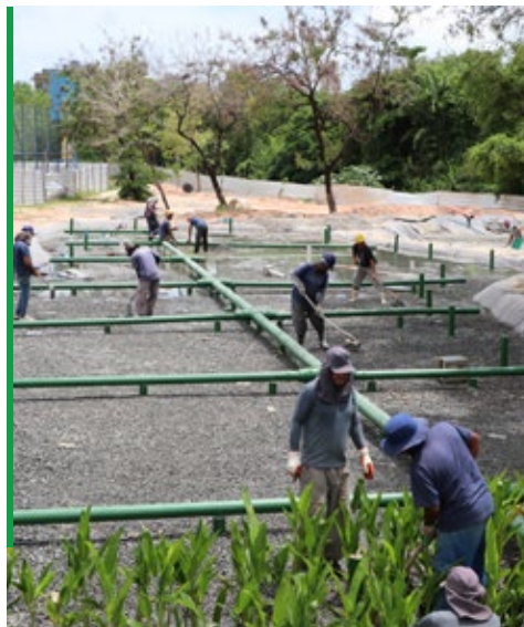
Obras do Jardim Filtrante.
